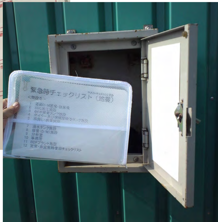
現場に備え付けられた チェックリスト例
